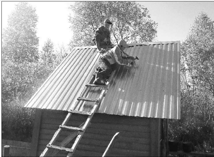
На строительстве водозаборного колодца.
