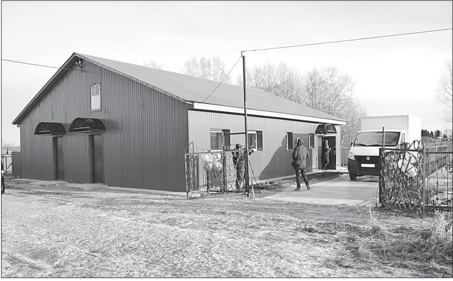
Здание нового убойного пункта.
