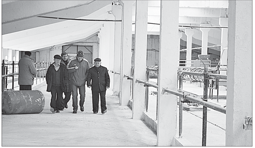
В помещении строящегося коровника.
