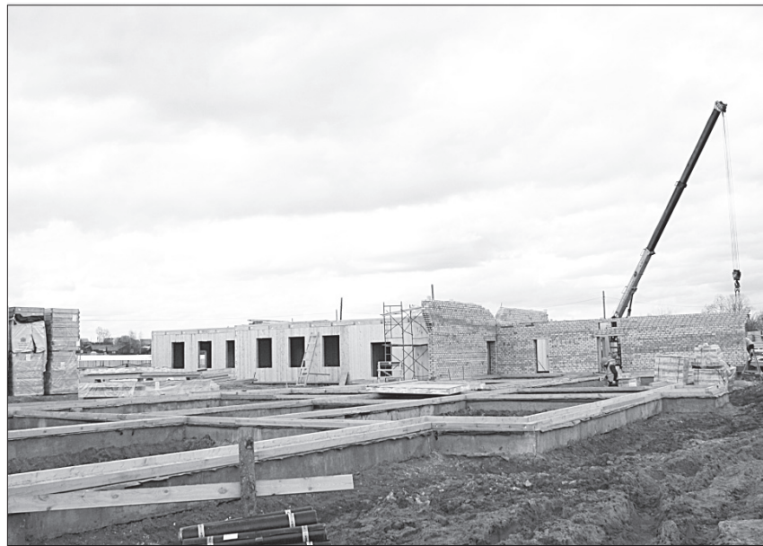
Строящийся детский сад в п. Первомайский.
