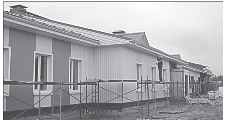
Завершается строительство детского сада в п. Первомайский.
